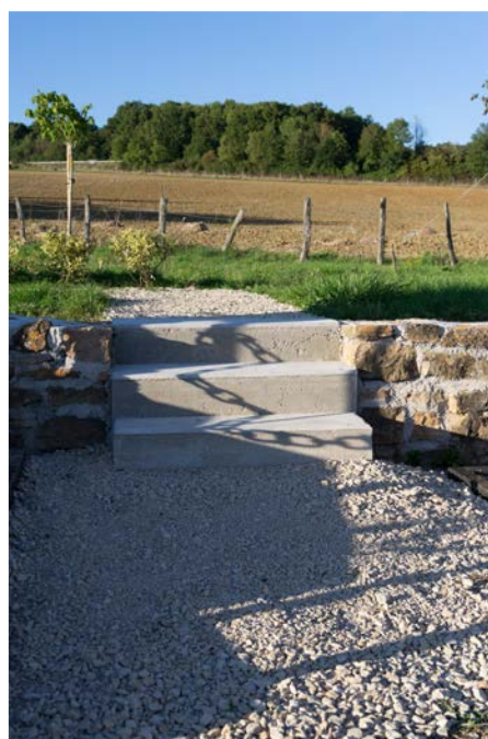
Escalier et muret du columbarium
